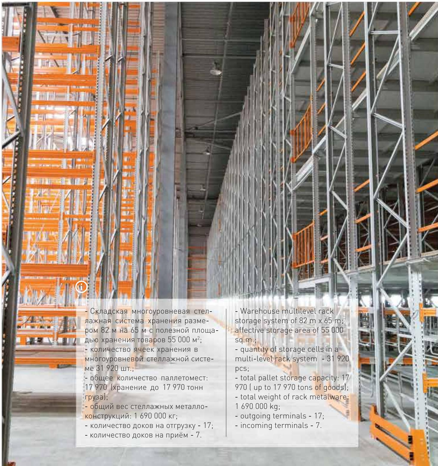
Начнем с многоэтажной стеллажной конструкции размером 82 на 65 м и высотой 12.8 м состоящей из 5 уровней. Общее количество полок около 32 000 штук. Общая площадь полезного хранения 55 000 м<sup>2</sup>, что эквивалентно десяти футбольным полям. Общий вес стеллажной конструкции 1 690 тысяч кило-
